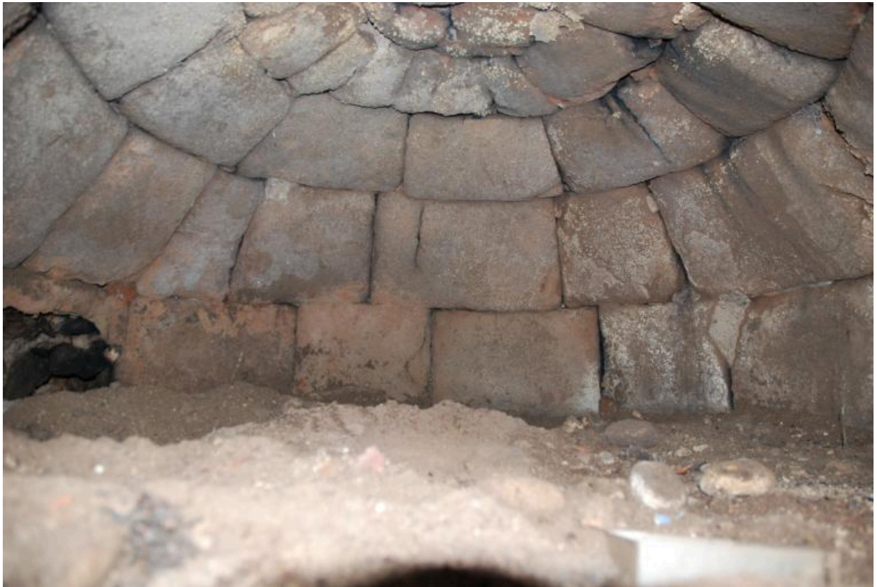
Détail de mise en oeuvre : voûte du four à pain.
