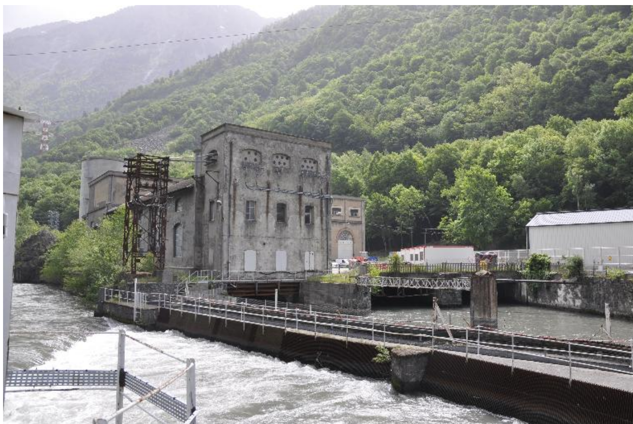
Vues des bâtiments de la centrale
