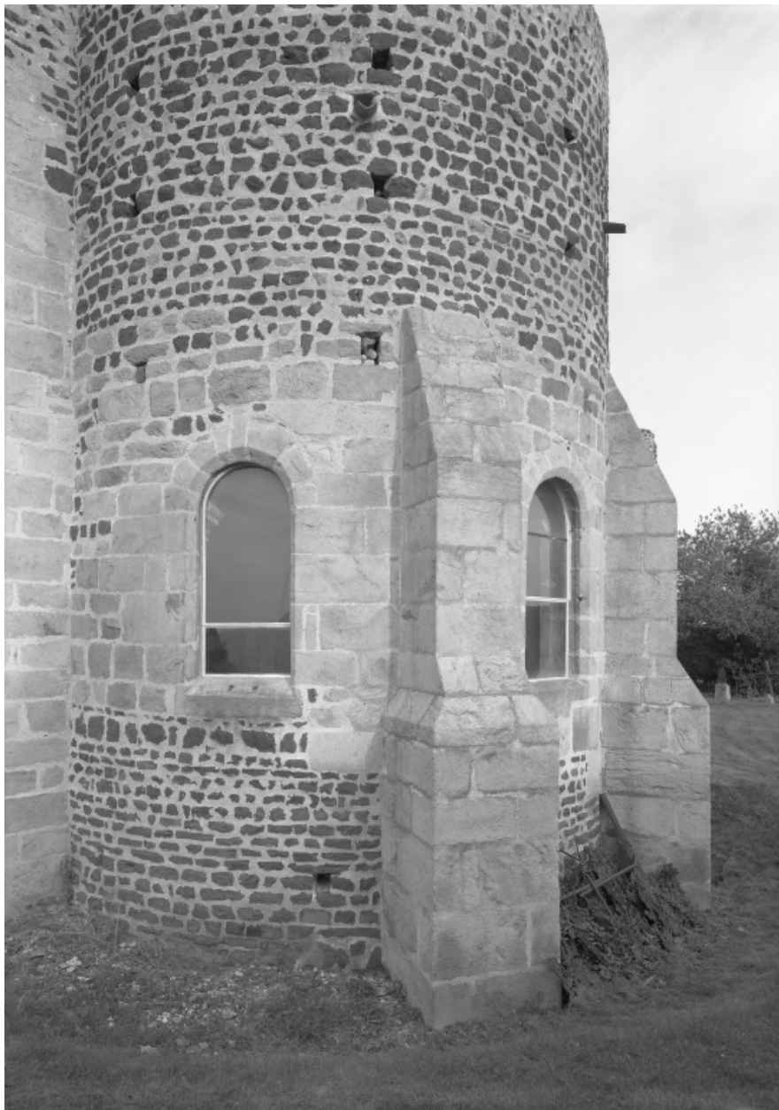
Vue partielle de l'abside, depuis le sud-est ; détail de l'appareillage en pierre de taille du pourtour des baies.
