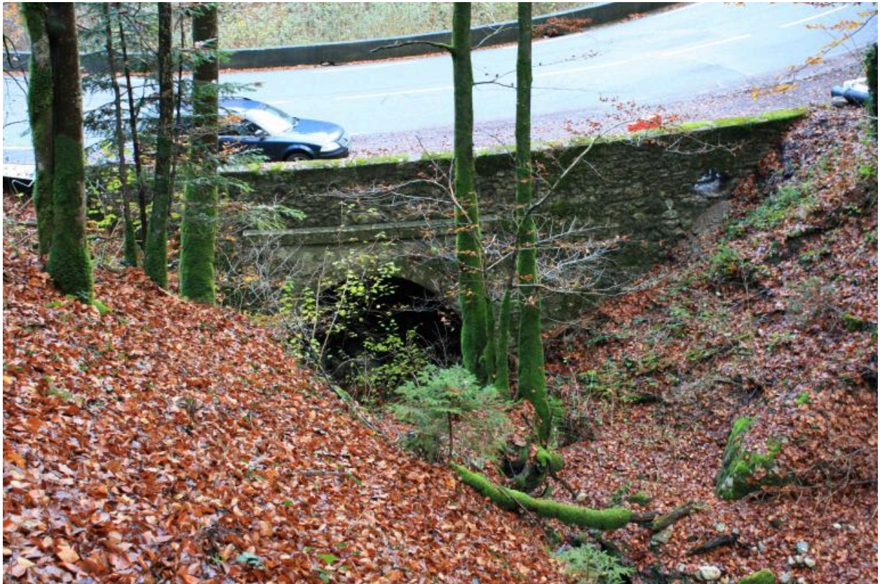
Pont de Trélachaud, face amont
