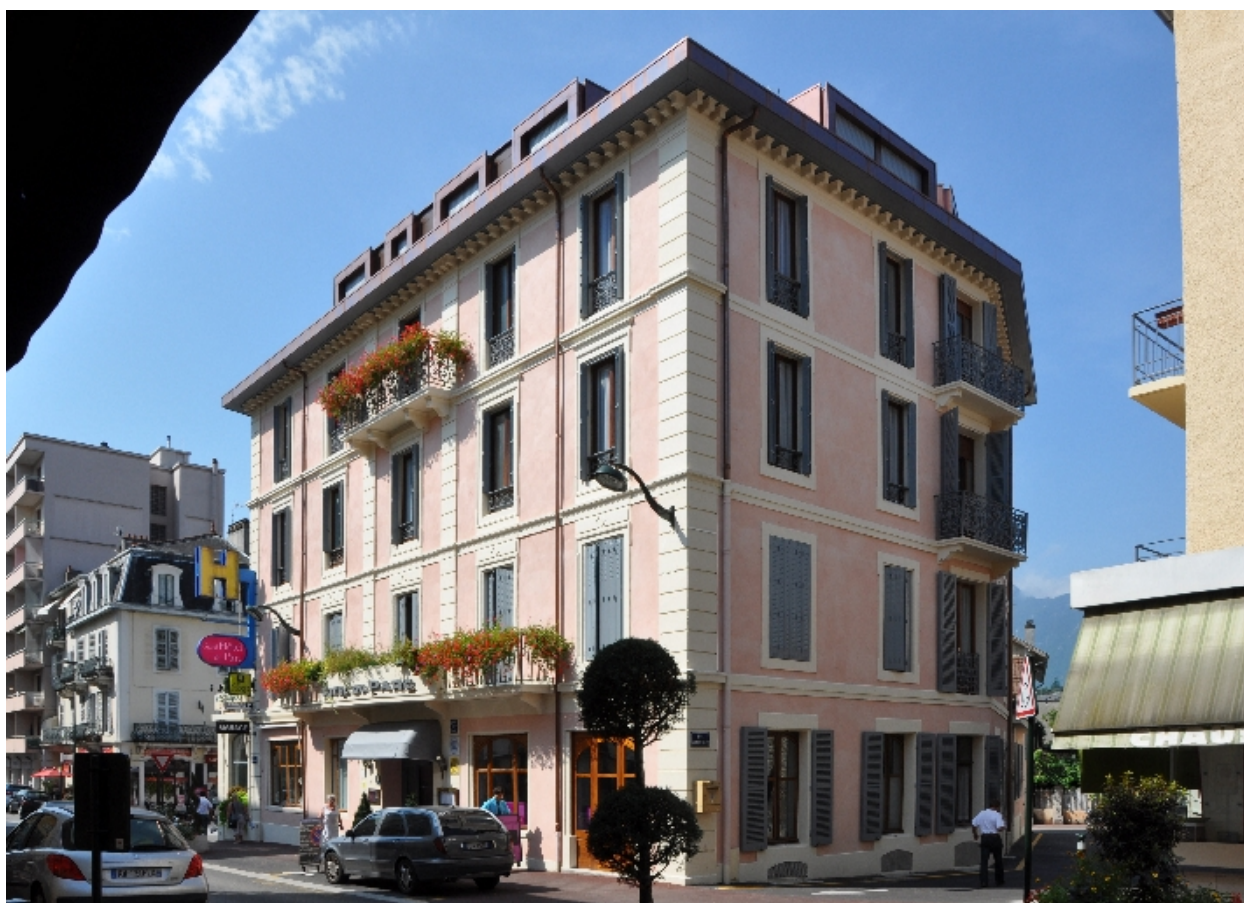
Bâtiment principal pris du nord-est
