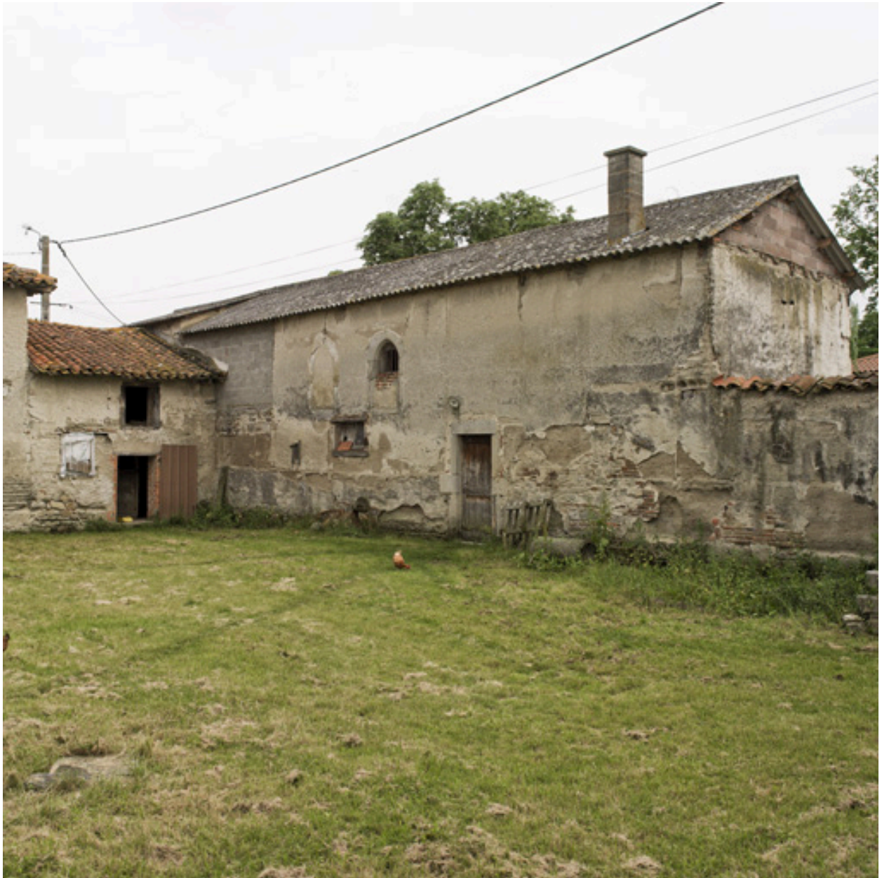
Vue de l'habitation du fermier, côté cour de ferme.
