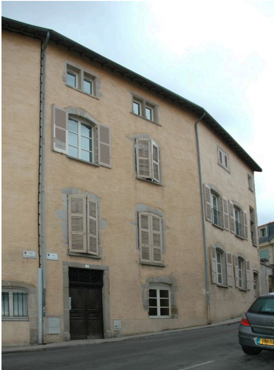
Vue partielle de l'élévation sur rue (partie droite)
