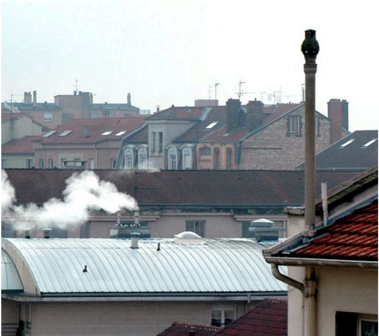
Vue du dernier étage de l'élévation postérieure depuis le nord-ouest
