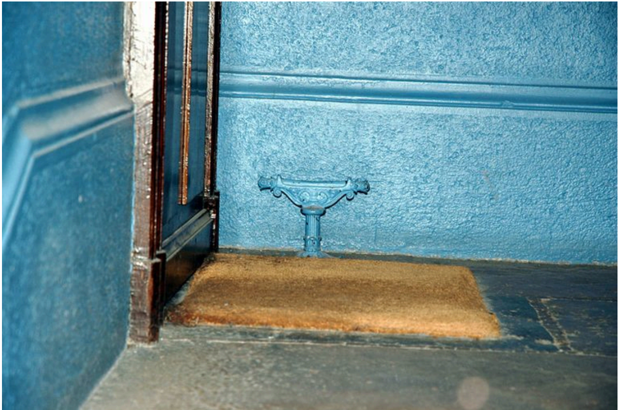
Corps de bâtiment sur rue : décrottoir sur palier
