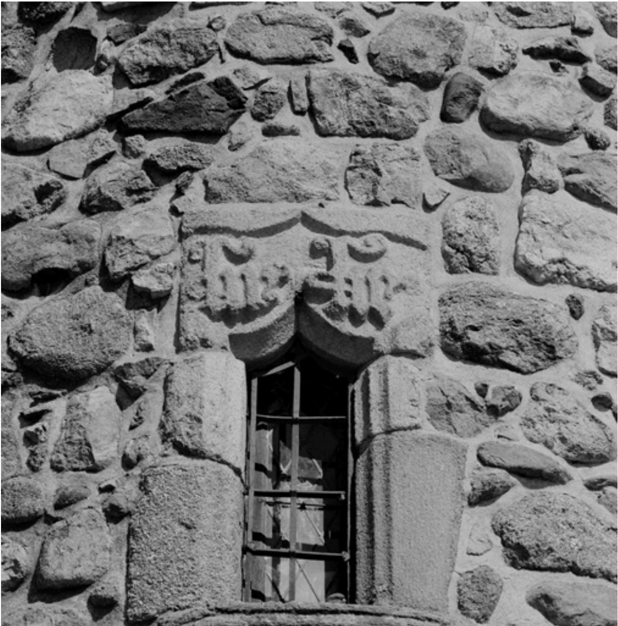
Détail de la fenêtre du 1er étage de la tour sud-ouest des bâtiments conventuels (monogramme du prieur La Perrière ?).
