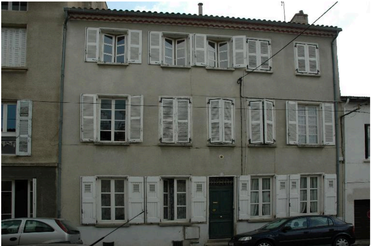
Immeuble, 4 rue des Moulins (AW 43)
