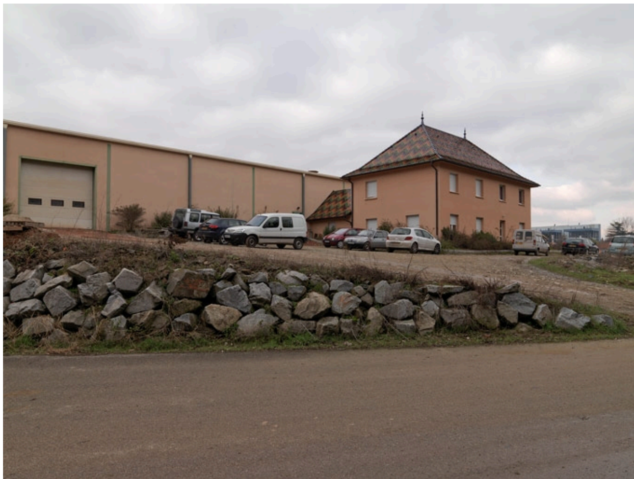
Vue du bâtiment administratif et de l'atelier
