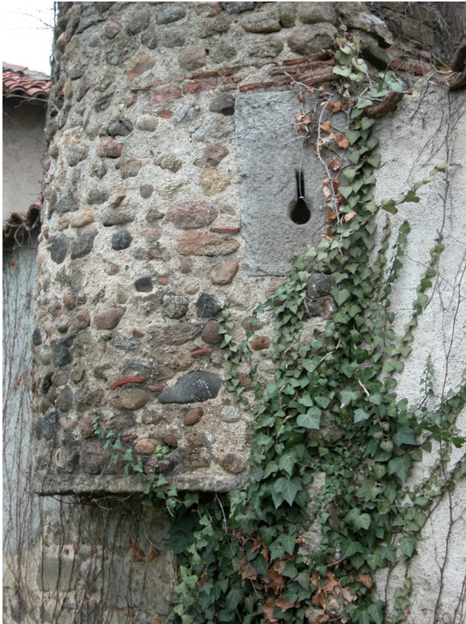
Vue de l'enceinte : échauguette, détail de cannonière.
