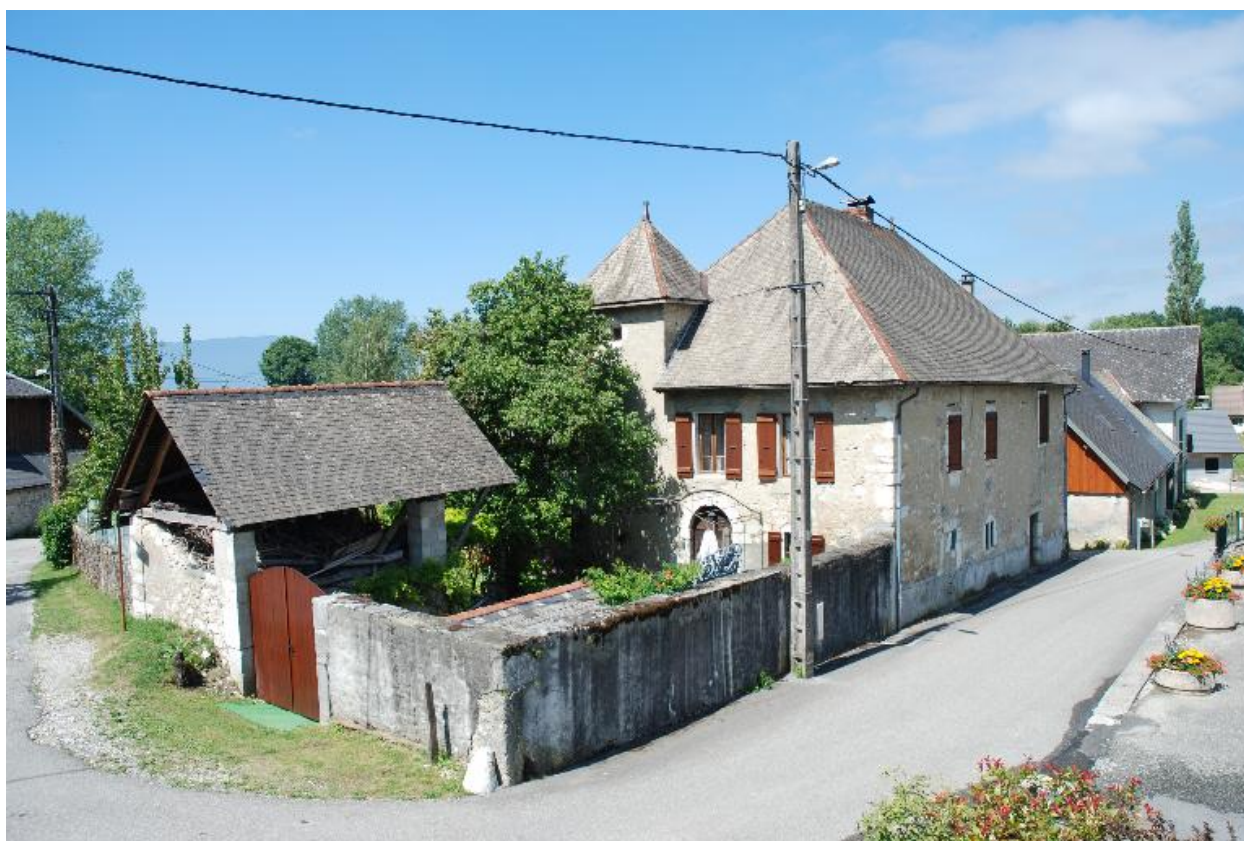
Vue générale de la maison depuis l'est.
