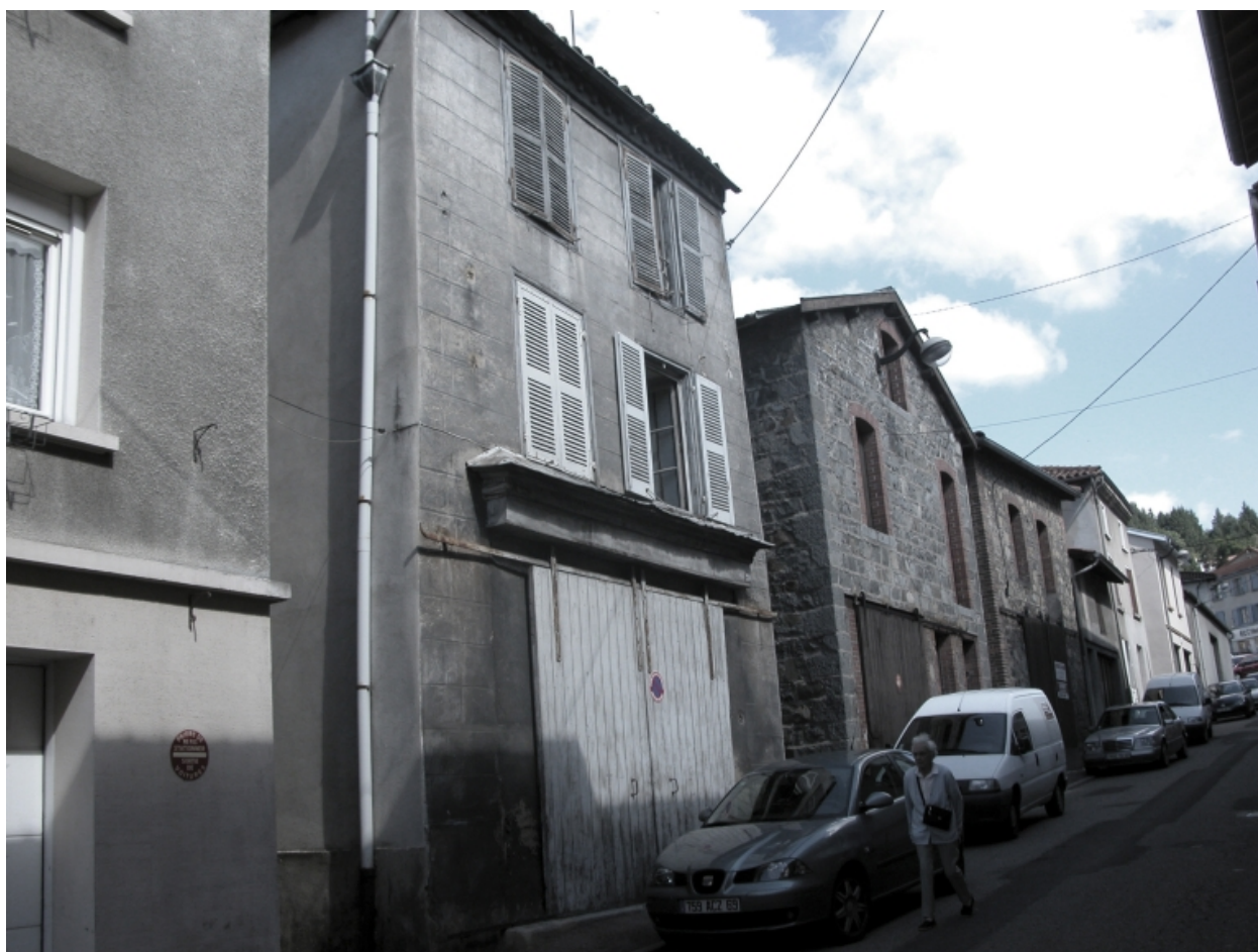
Îlot 2. Saint-Jean (rue) 30, 32, 34. Vue générale des façades sur rue avec présence des traversières dans la rue du Vieux Pressoir.
