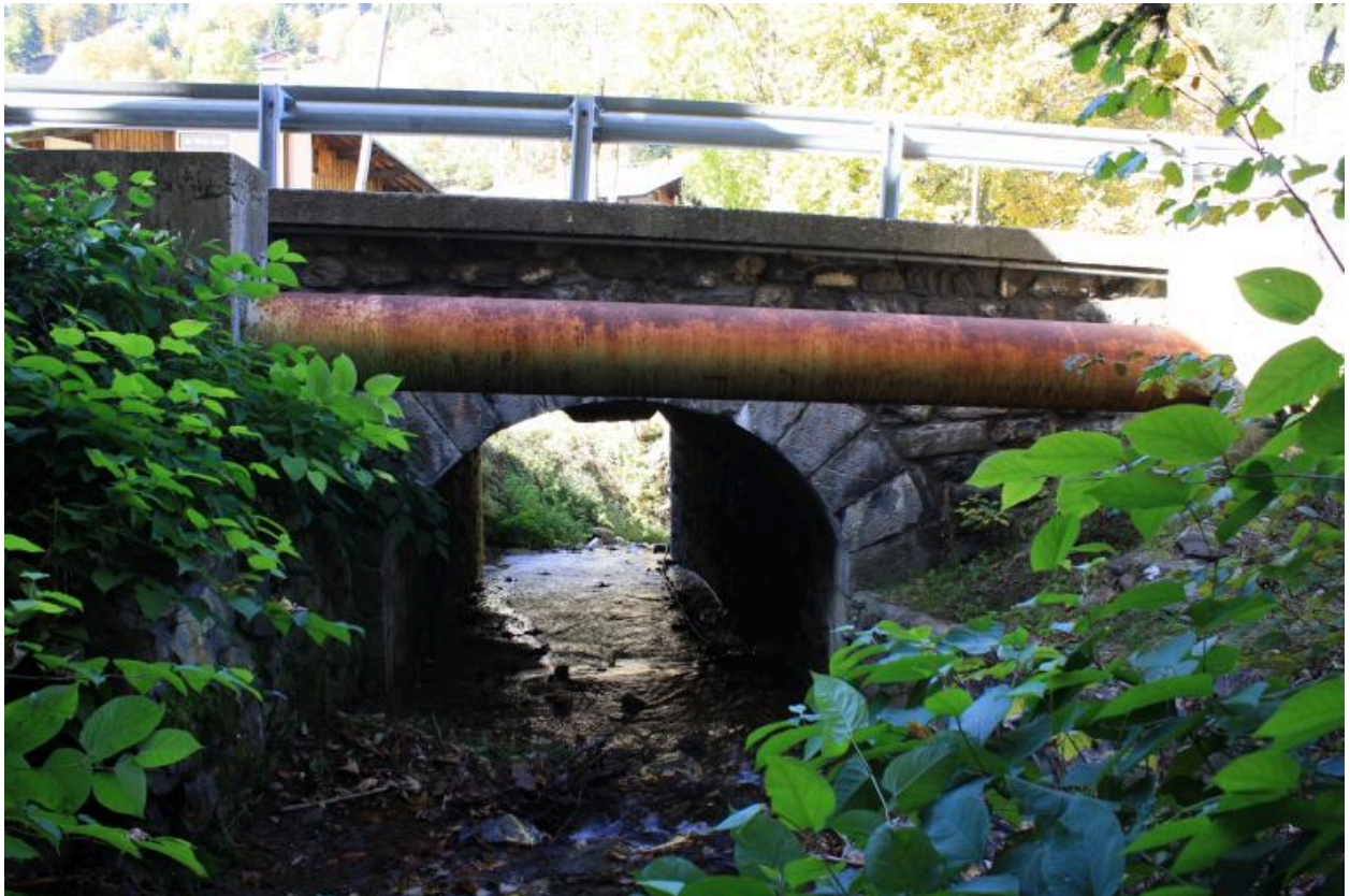
Pont du petit Nant, face amont
