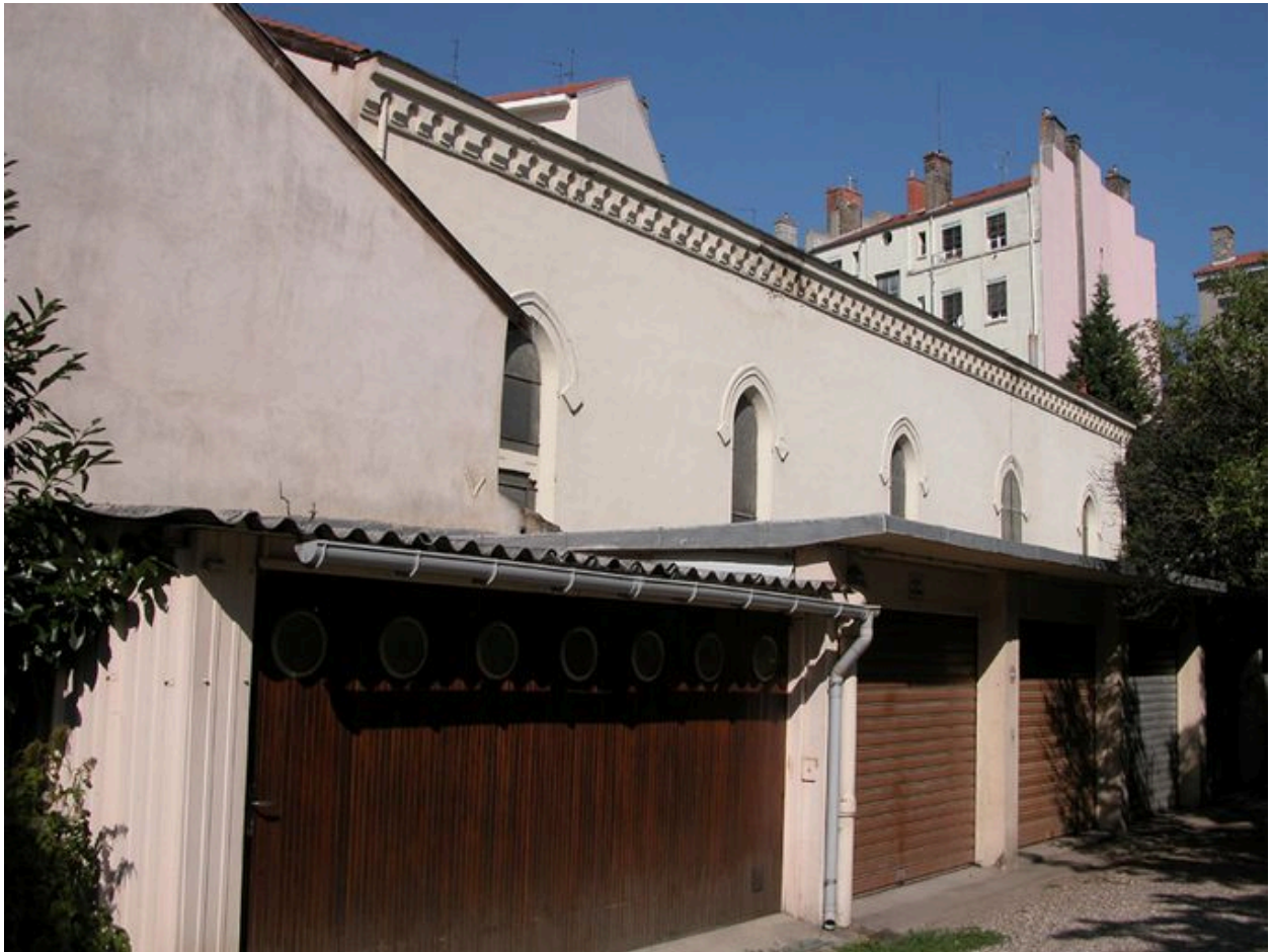
Chapelle, élévation nord, vue générale
