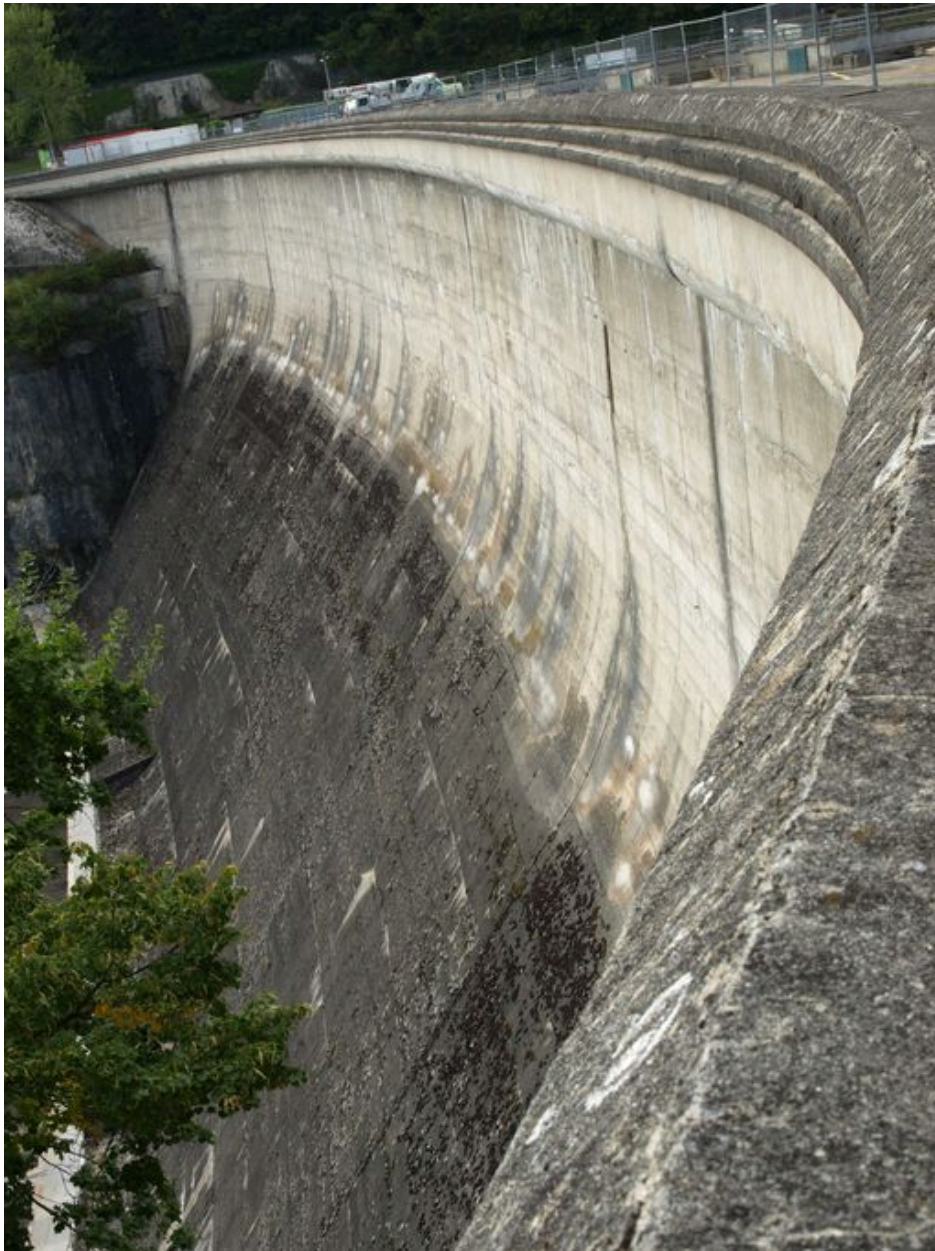
Vue partielle : face amont
