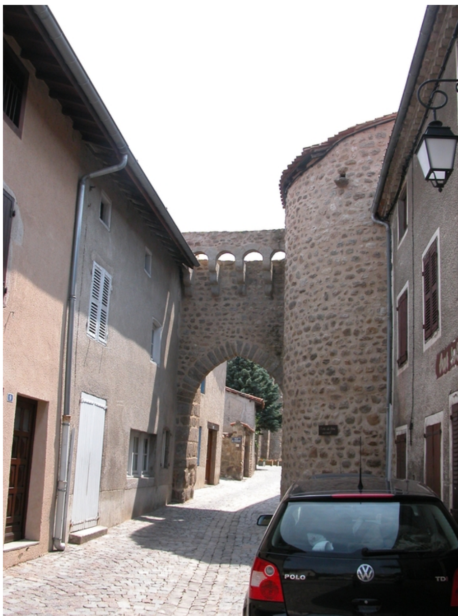
Vue générale depuis le nord (état en 2006).
