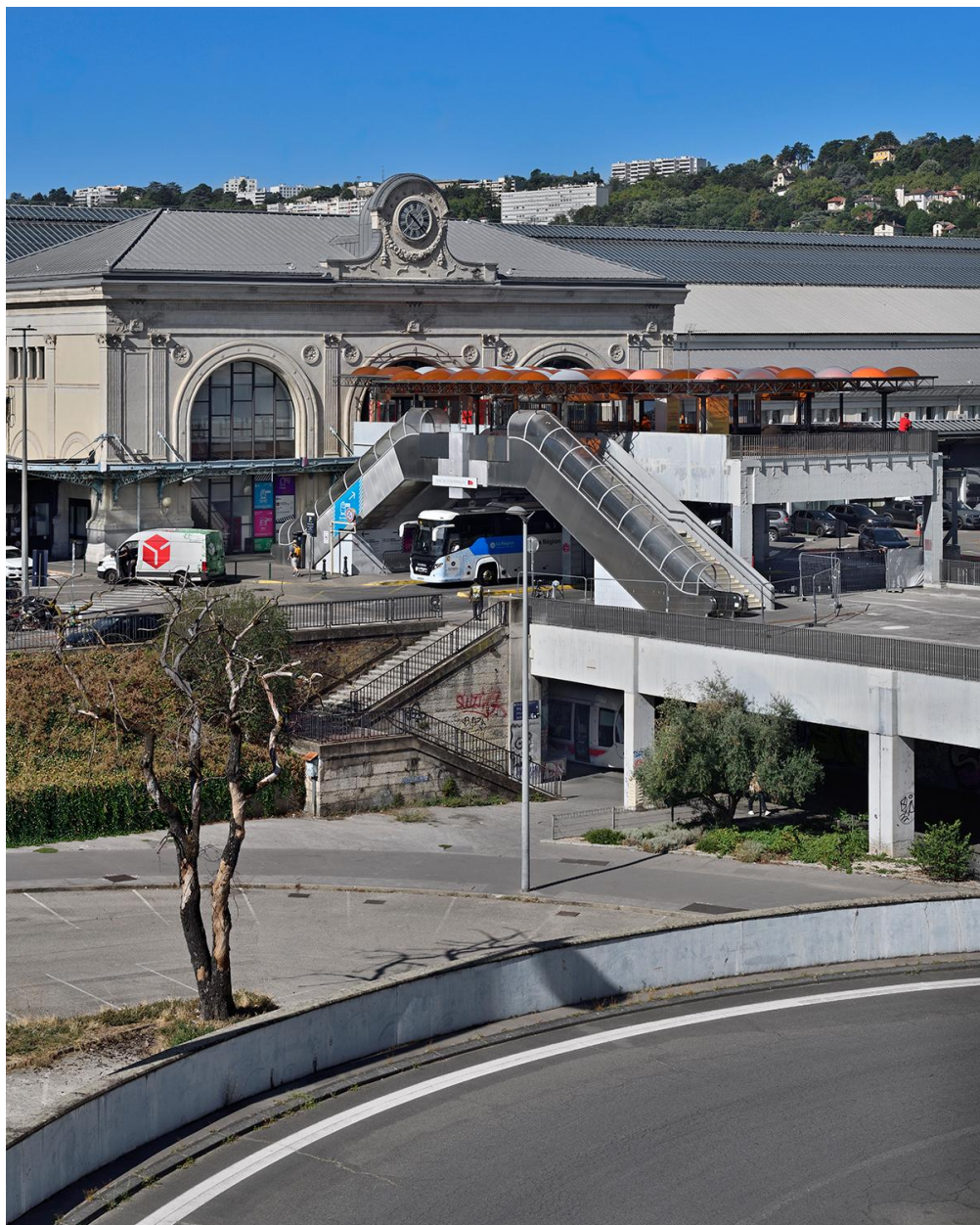
Été 2026 : l'élévation nord du bâtiment voyageurs
