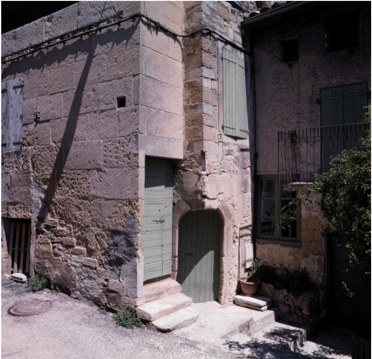
Le Village. Vue partielle d'une maison (A2 1059 ?).
