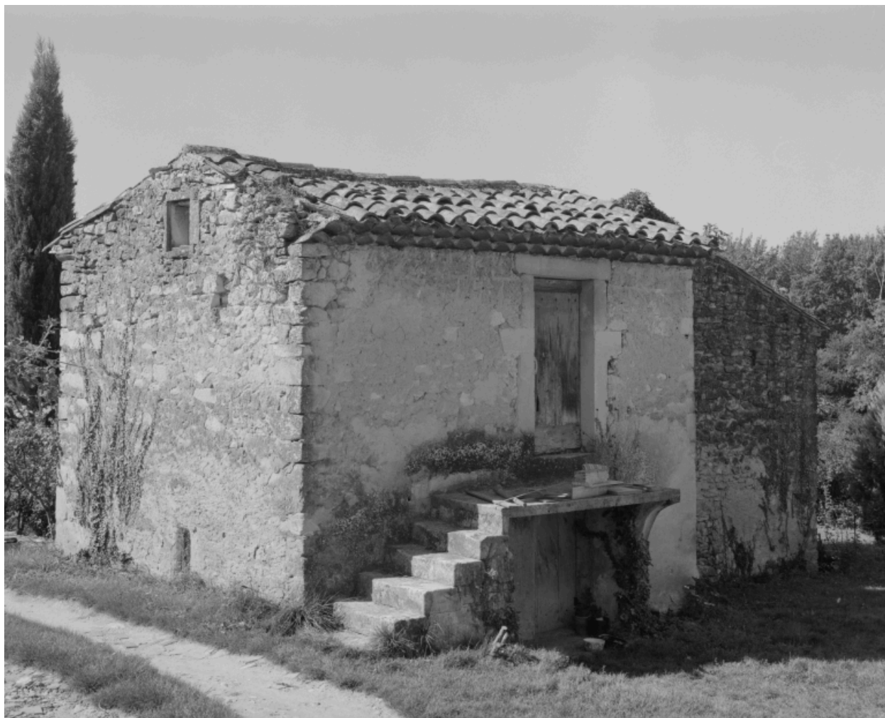
La Valadière. Une dépendance de la ferme parc. B 193-194.
