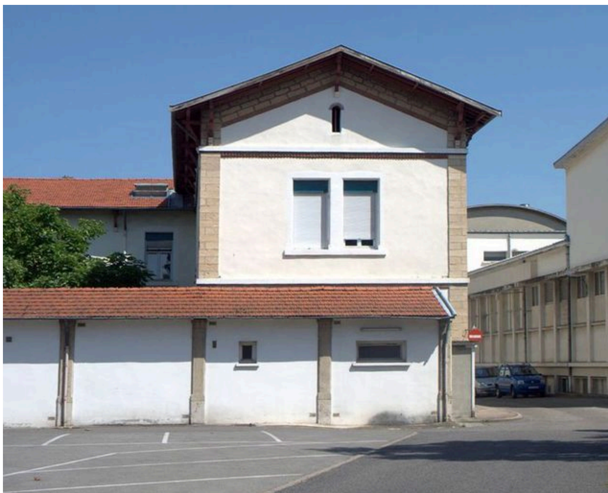
Façade principale (ouest) : aile latérale sud et départ de la galerie transformée en bâtiment
