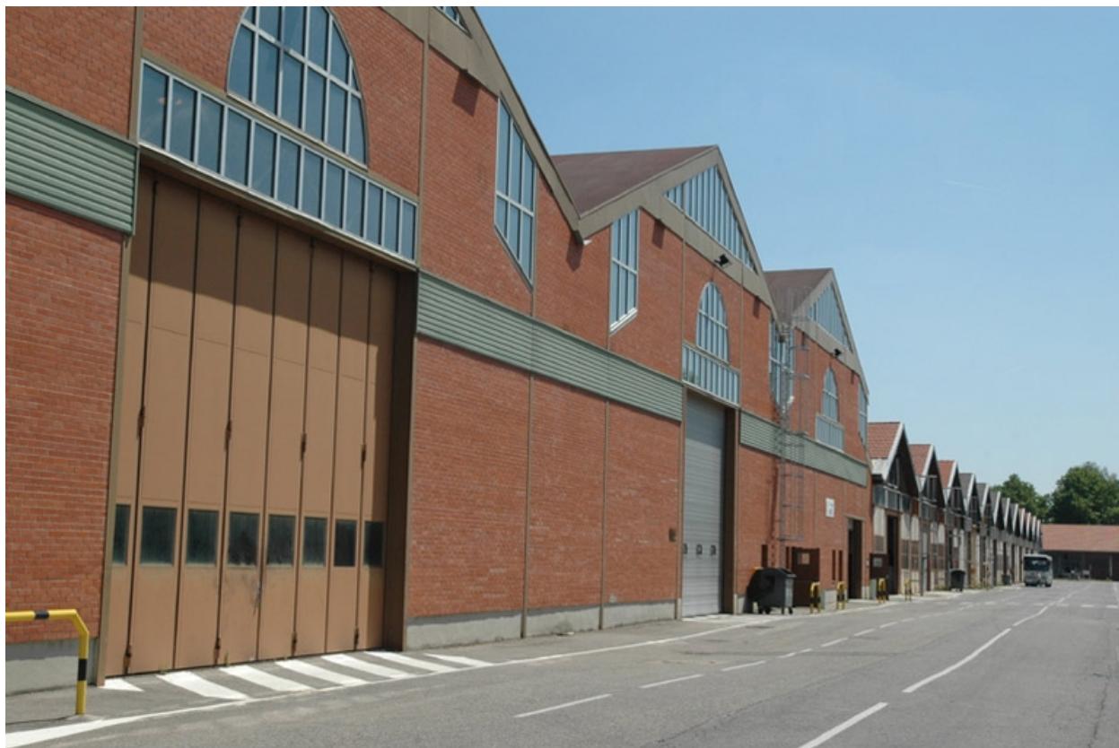
Ateliers de stockage, bâtiment n° 43
