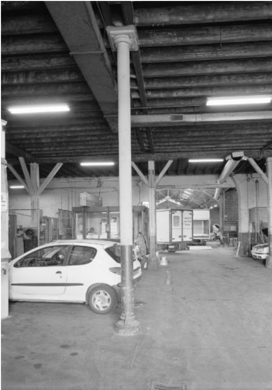
Vue d'ensemble du hangar quai Perrache, depuis l'entrée
