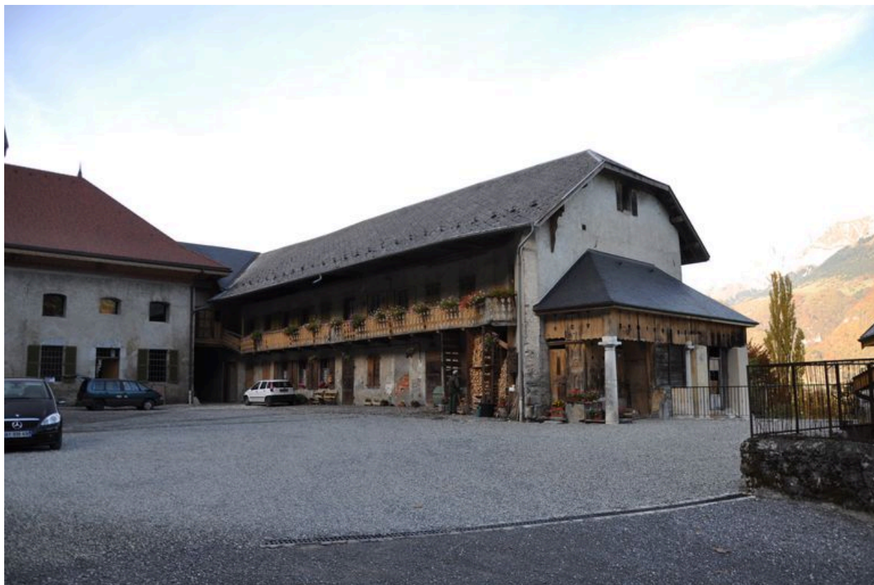
Bâtiment des écuries
