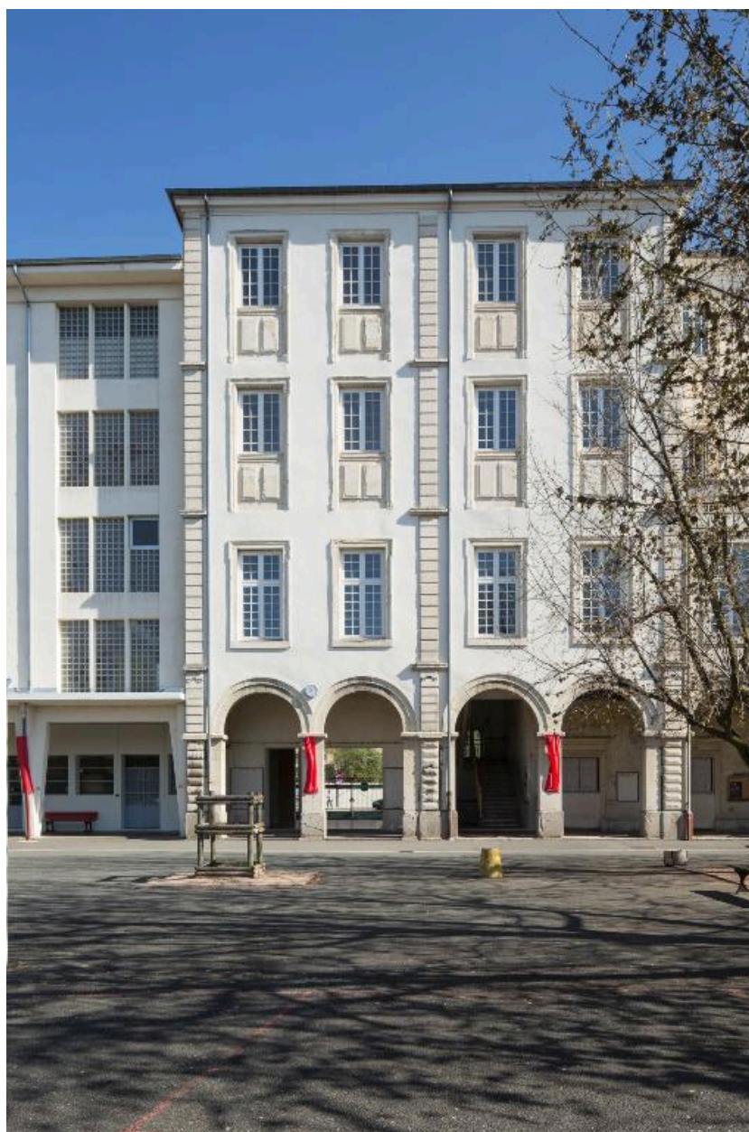
Bâtiment H. Côté cour, travée de l'entrée
