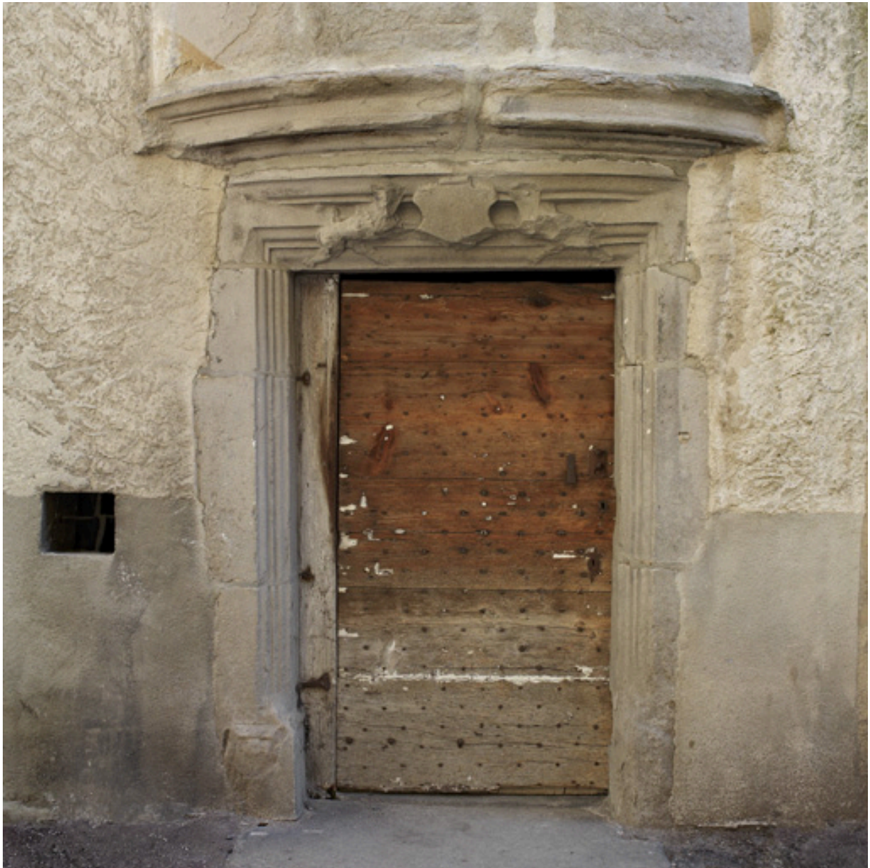
Porte piétonne de l'escalier en vis demi hors oeuvre, sur la rue Chenevotterie.
