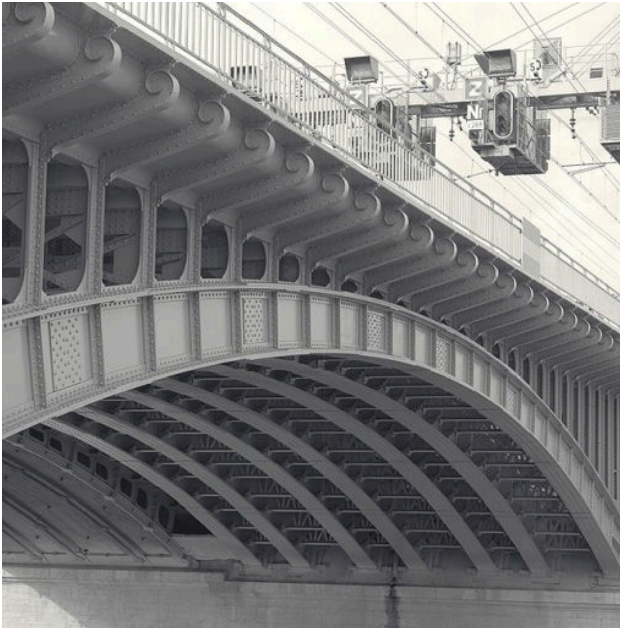
Détail d'une arche depuis le nord
