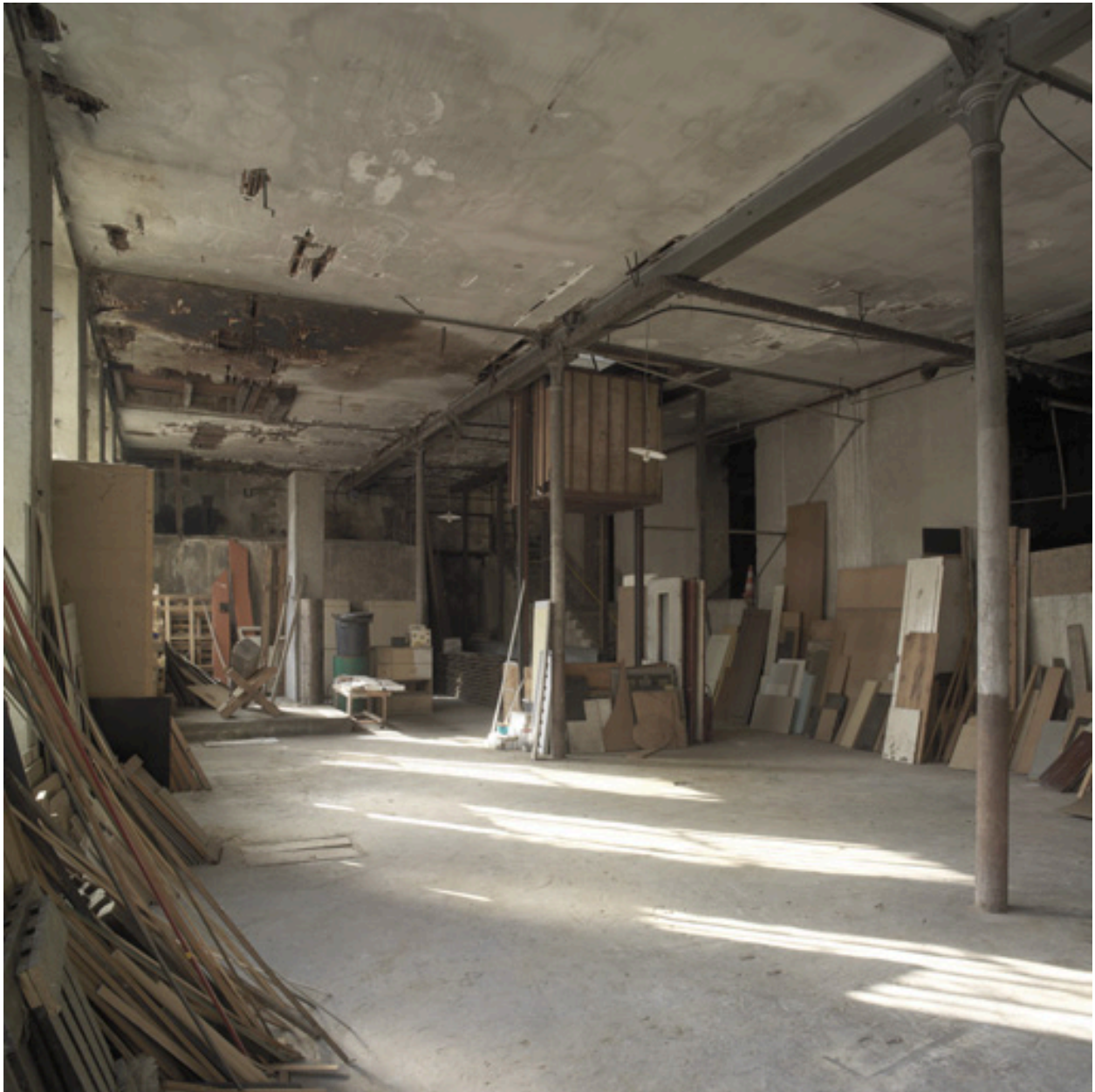
Vue intérieure de l'étage de soubassement, depuis le sud-est.
