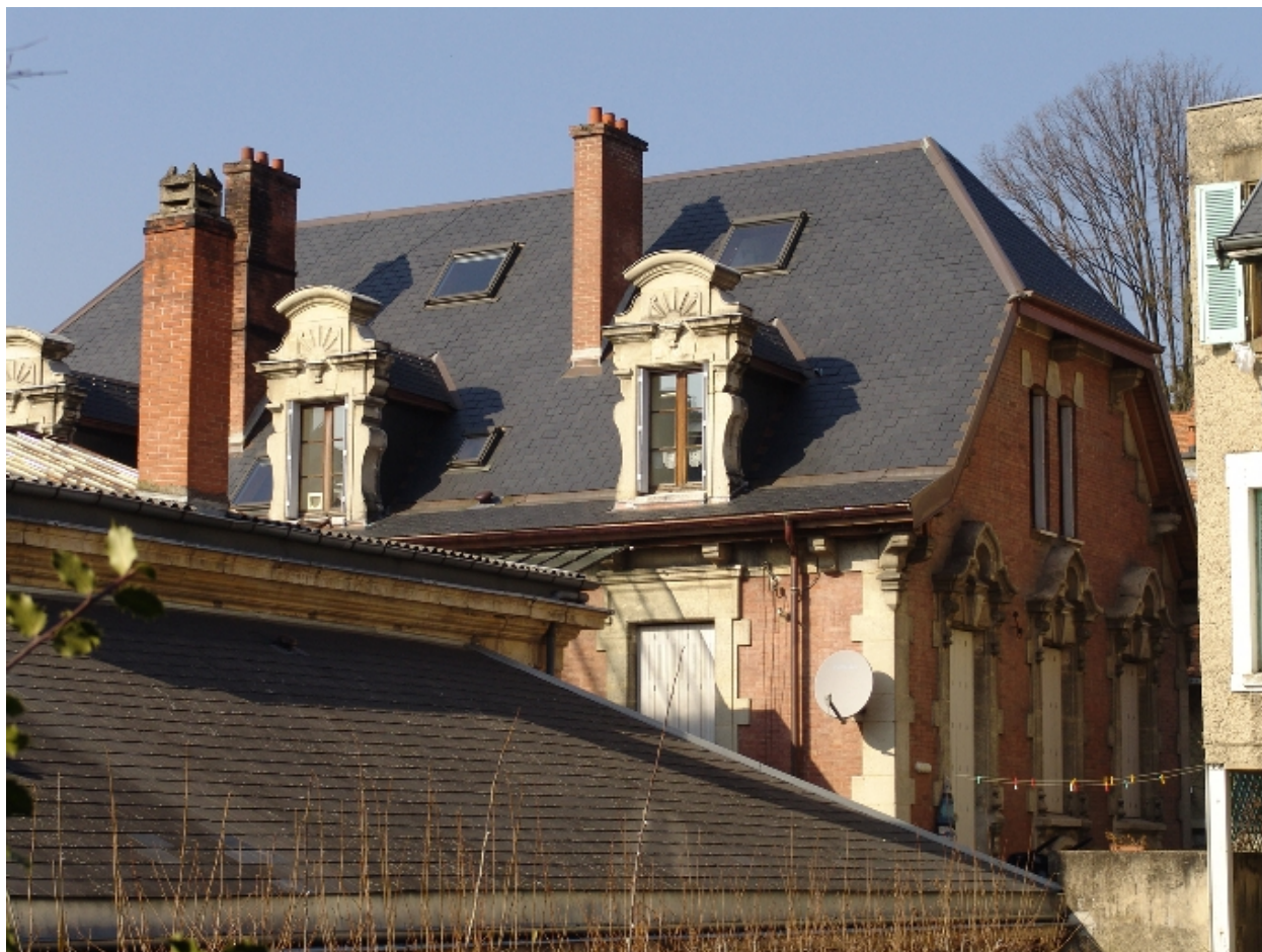
Toiture du bâtiment principal
