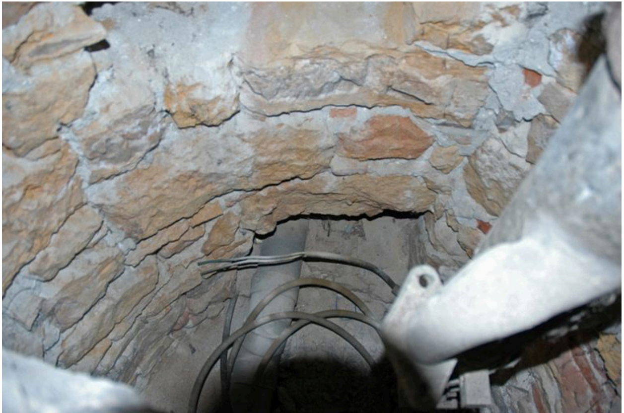
Vue de l'intérieur du puits
