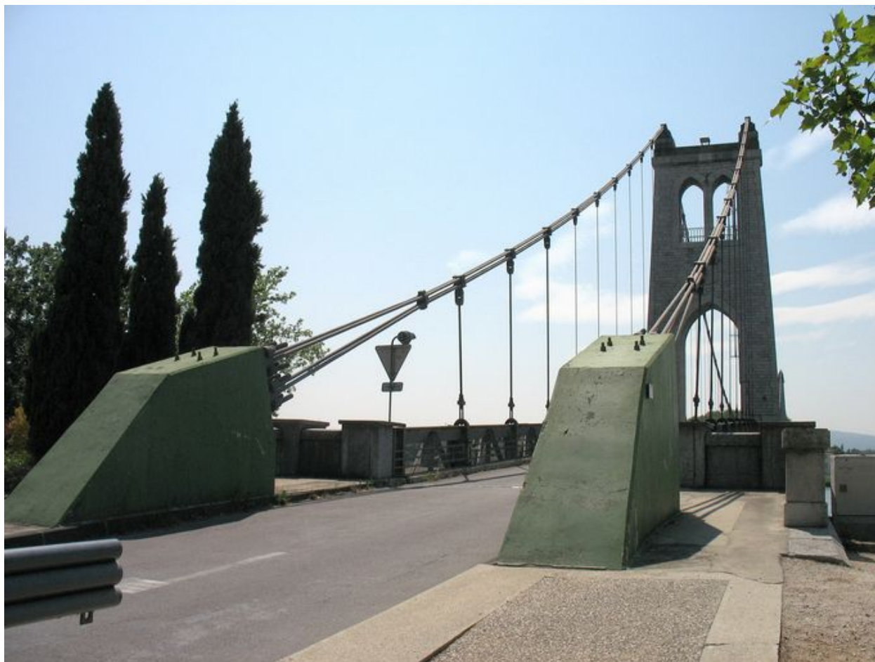
Vue du pylône côté La Voulte, câbles et massifs d'ancrage
