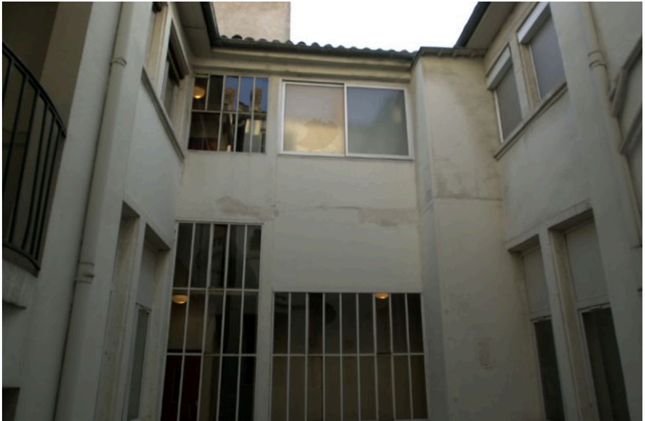
Cour nord, vue des 3e et 4e étages
