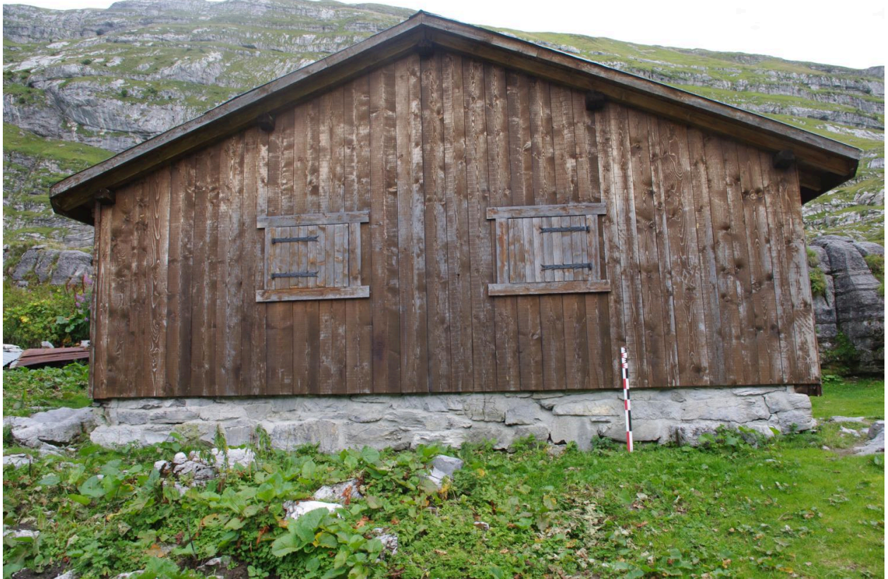
Vue du mur pignon ouest
