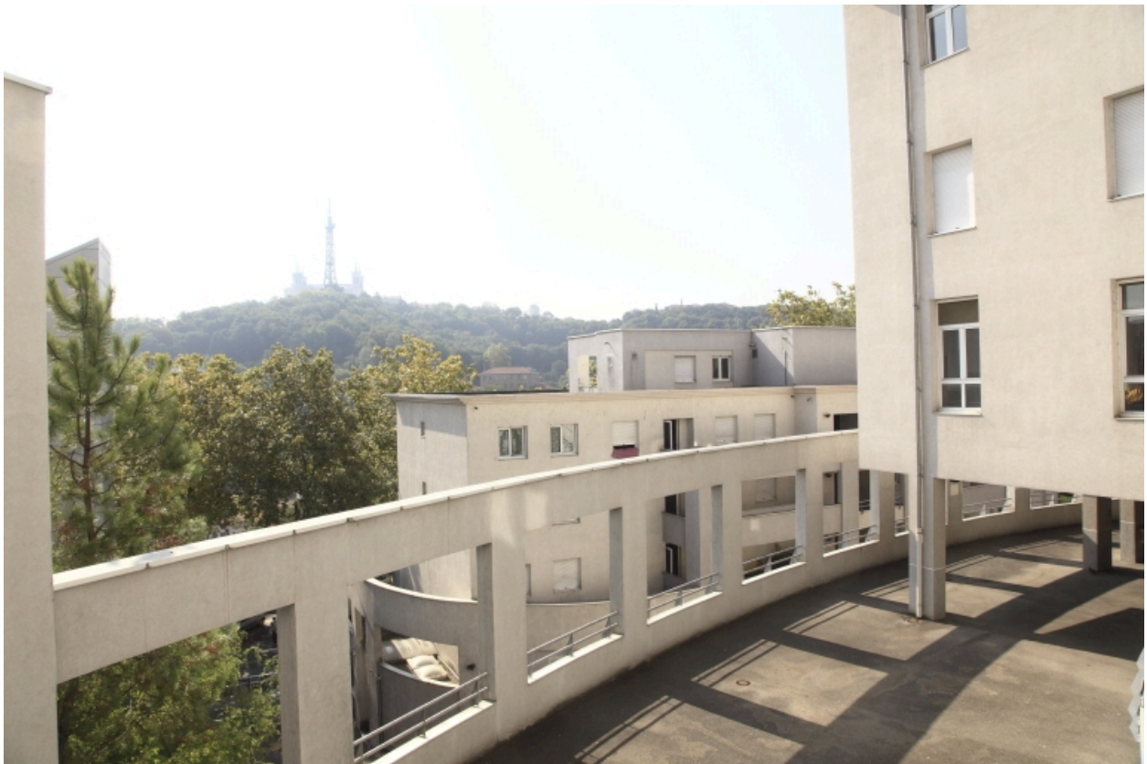
Vue extérieure. Terrasse supérieure.
