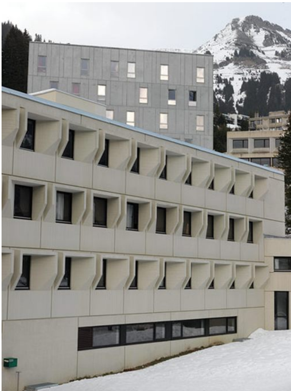
Elévation principale. Détail
