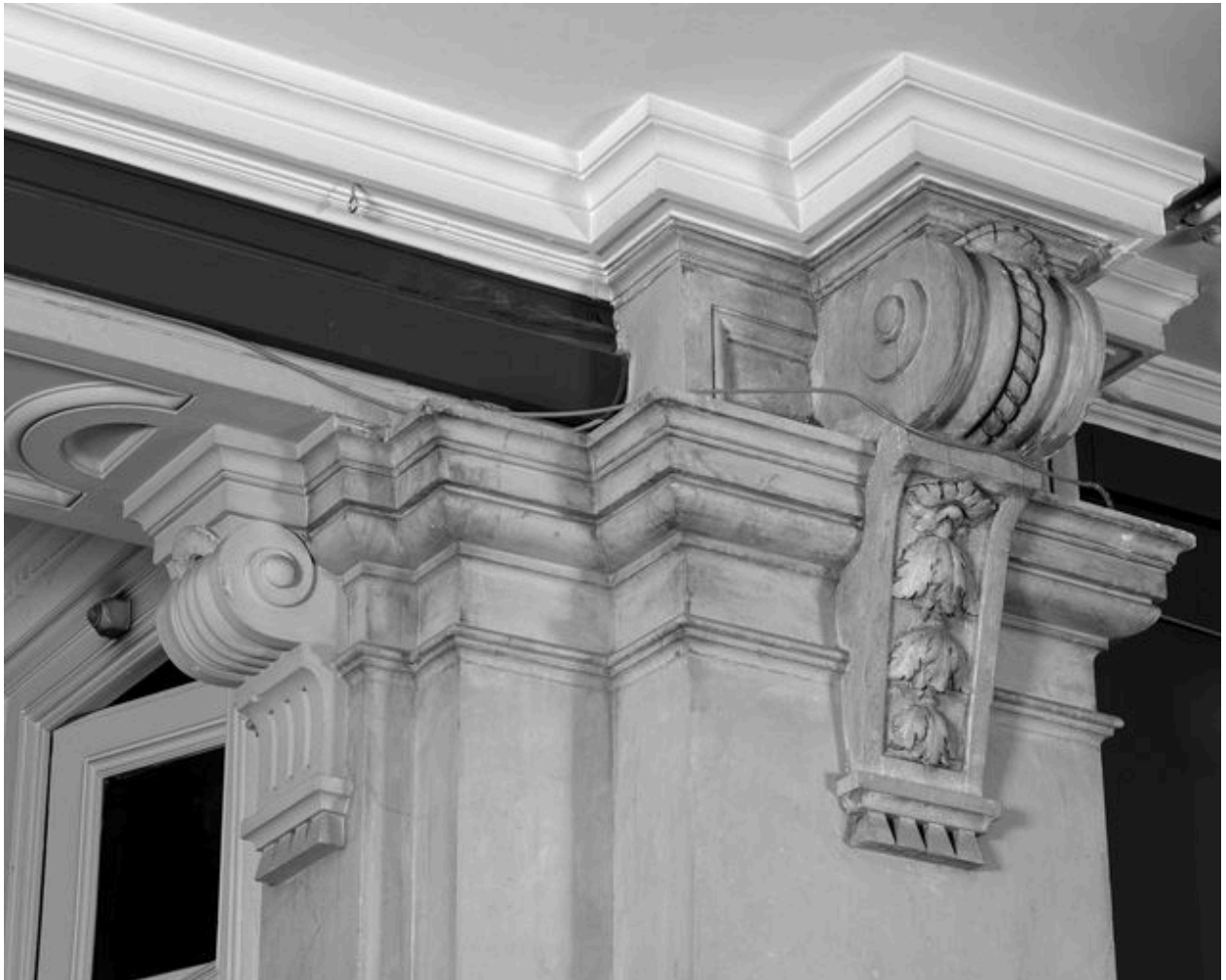
Consoles ornant le palier situé entre l'escalier principal et la grande salle, ancienne patinoire
