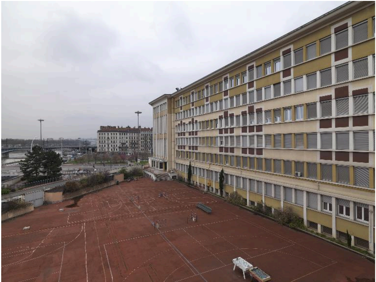
Bâtiment principal, élévation postérieure, depuis le nord
