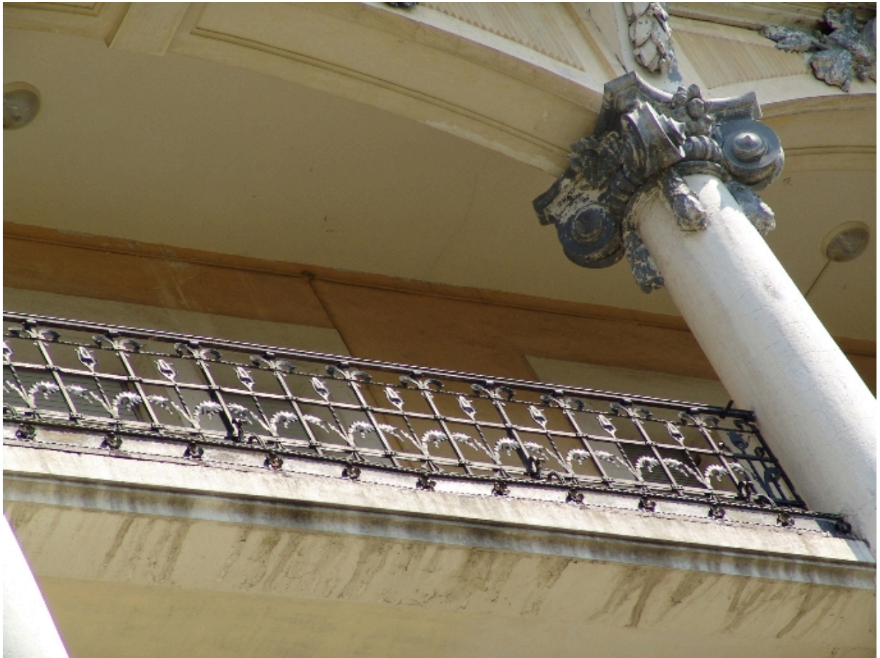
Façade nord-ouest : détail d'une loggia
