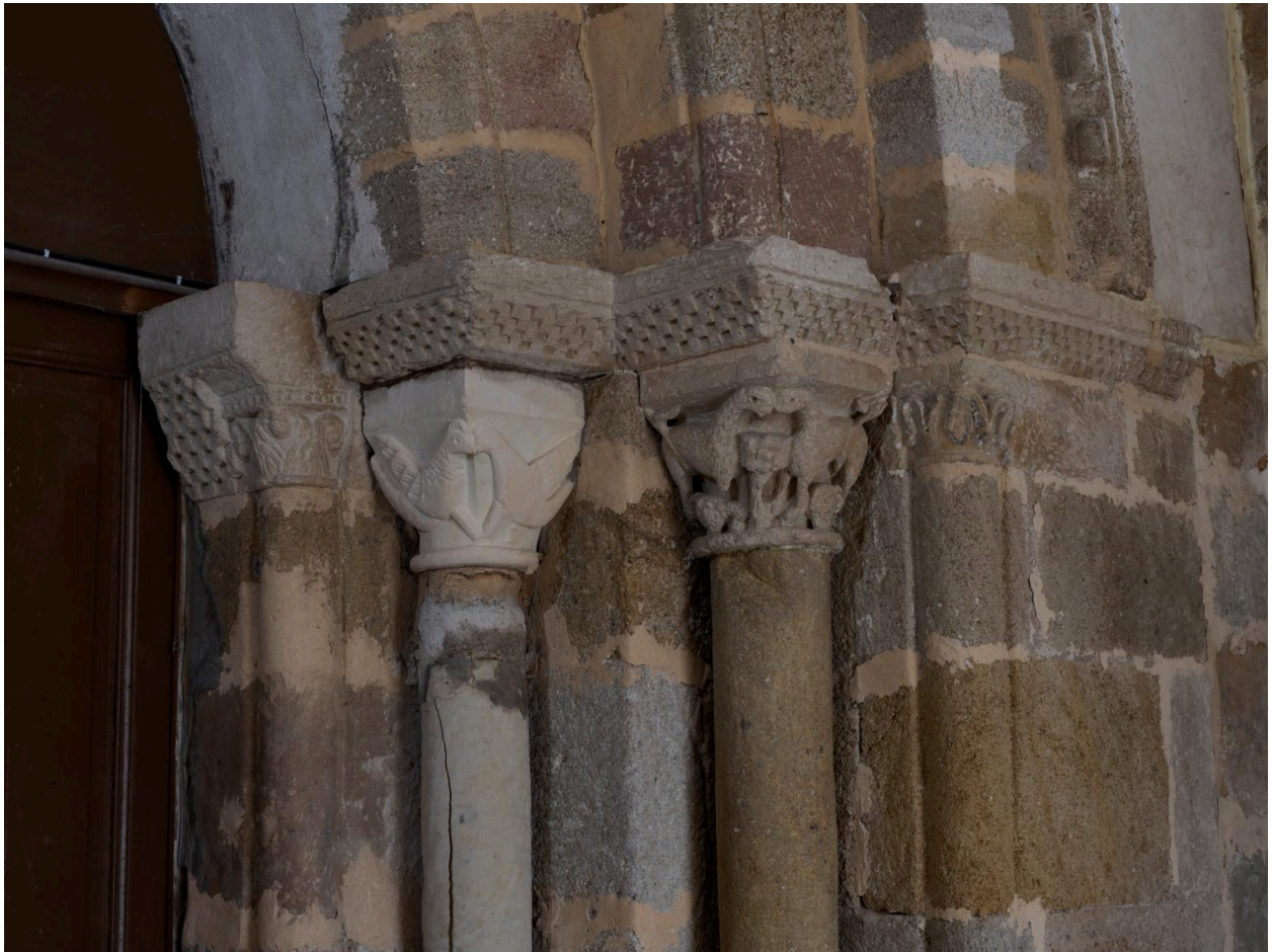
Détail des chapiteaux au sud de l'ancien portail occidental.
