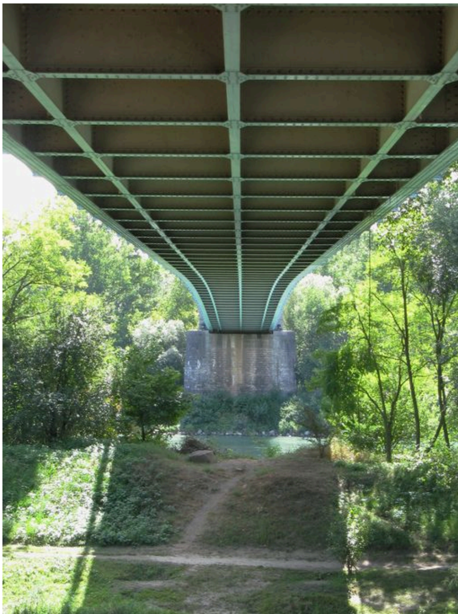
Vue partielle, de dessous, tablier et pile (depuis la rive droite)
