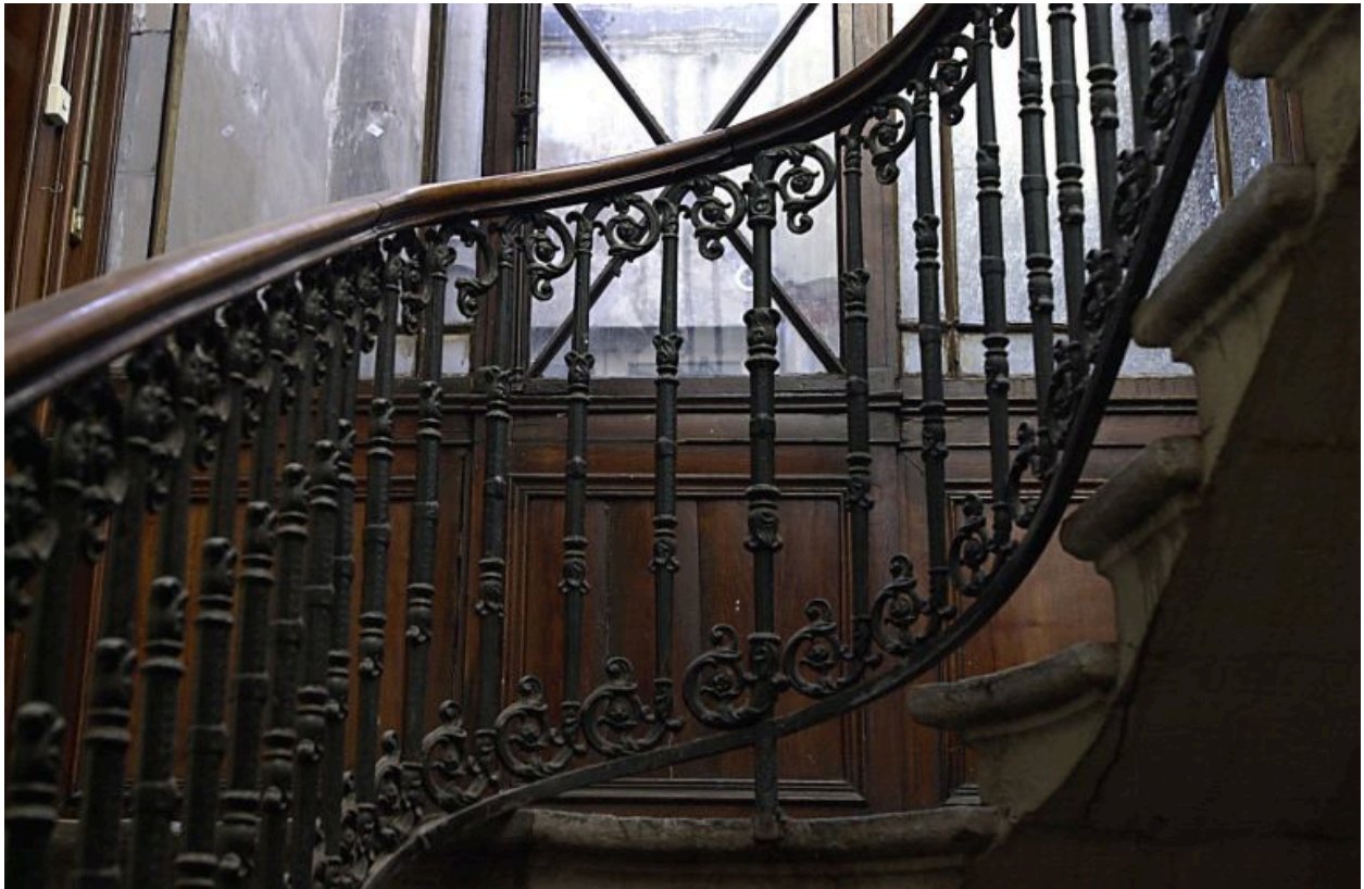
Escalier, détail de la rampe
