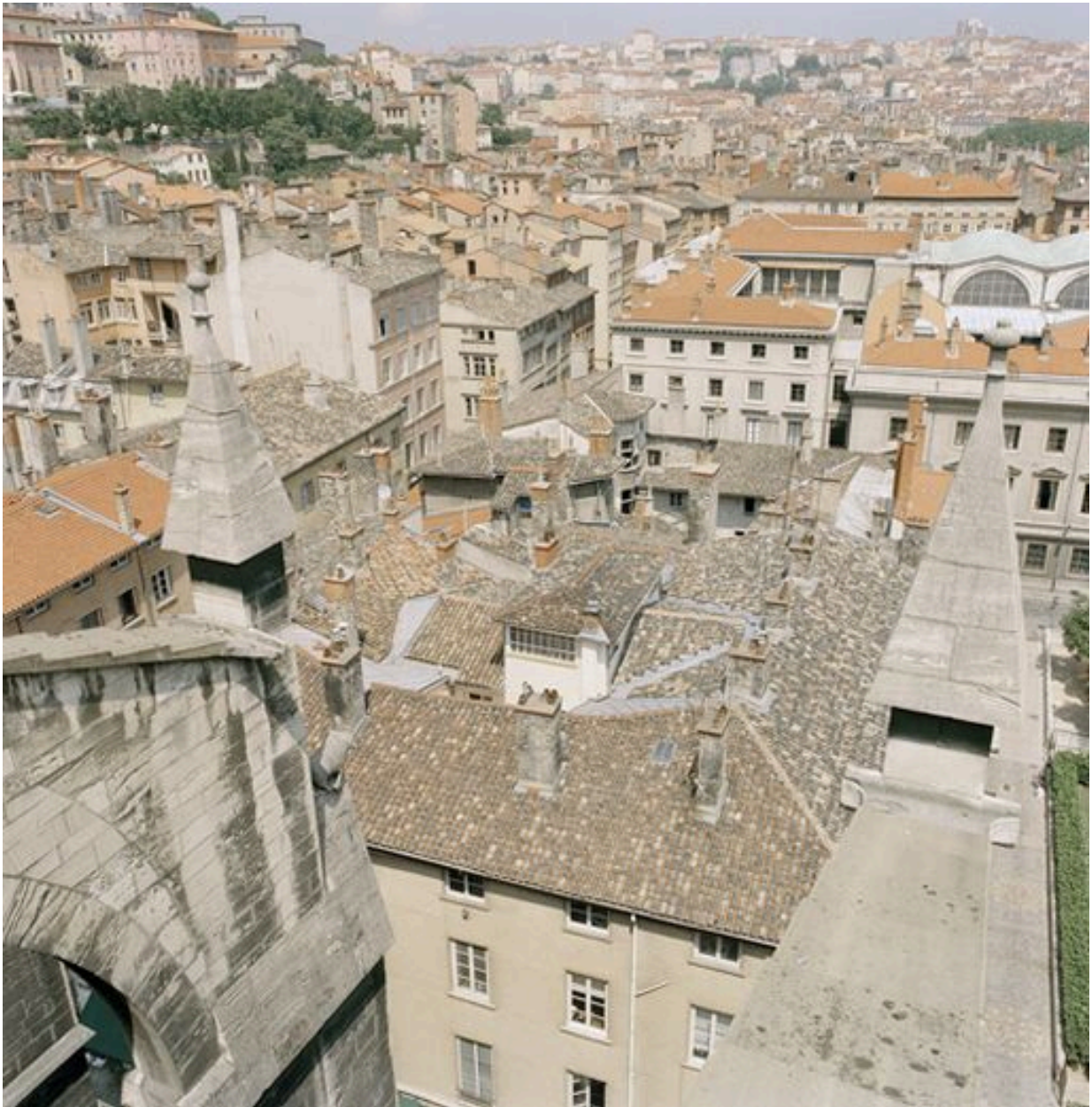
Partie ouest depuis la toiture de la cathédrale Saint-Jean
