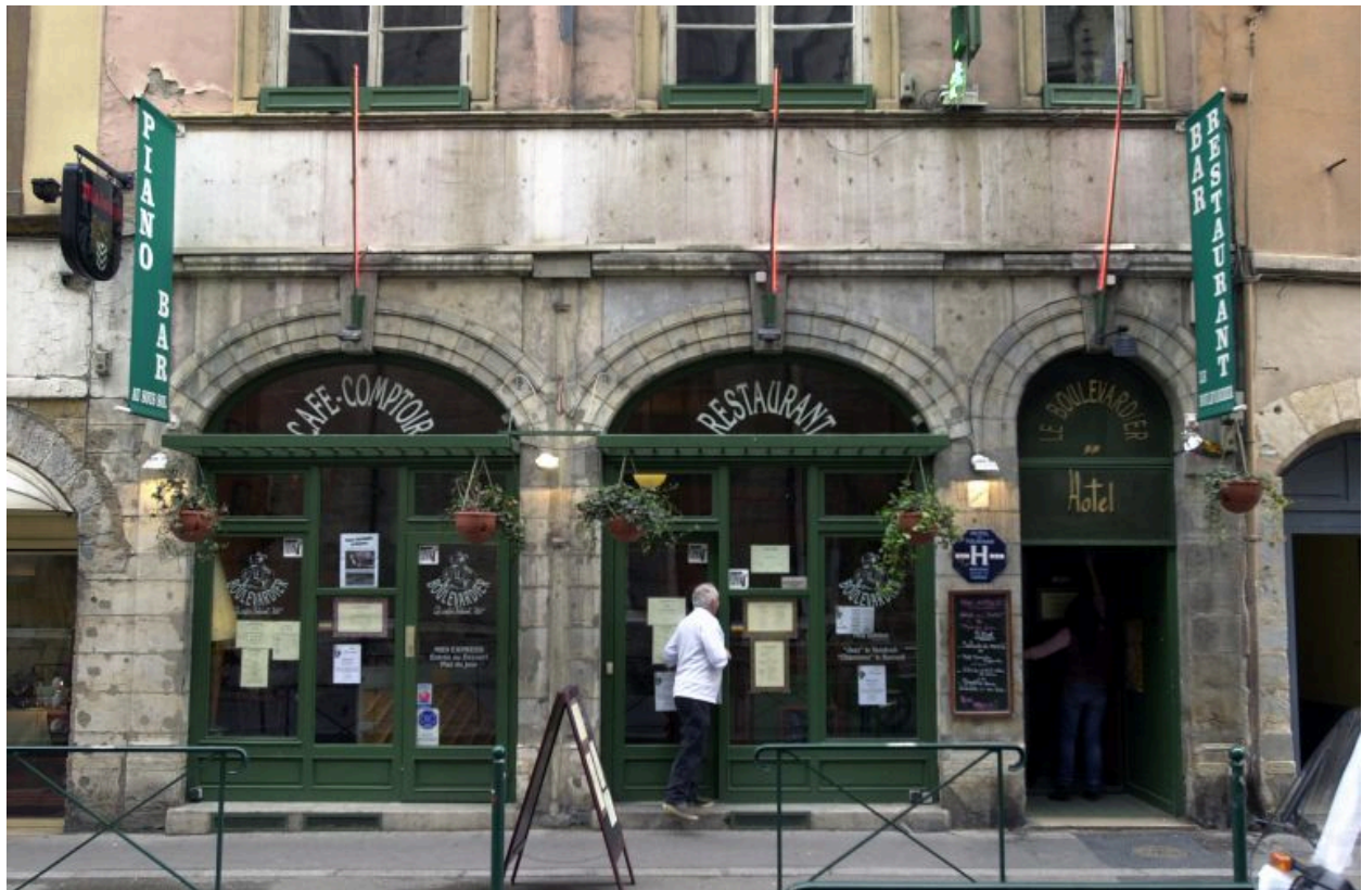
Façade sur rue, rez-de-chaussée
