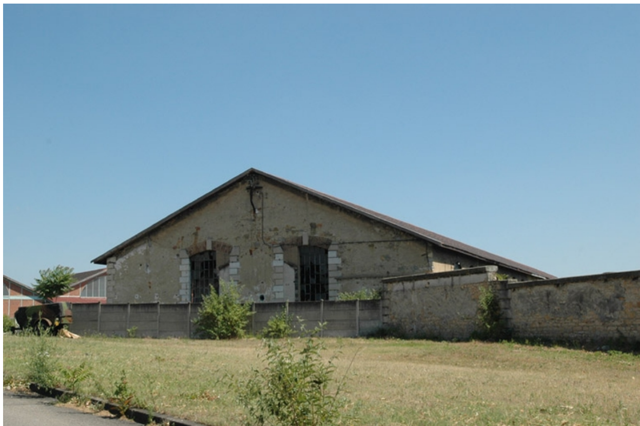
Pignon nord de la halle qui va être démolie
