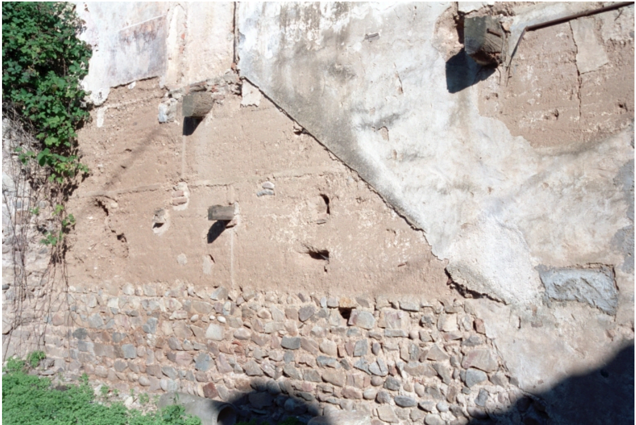
Boën, îlot 12, Ph. Raymond (rue) 21. Détail du matériau de construction.
