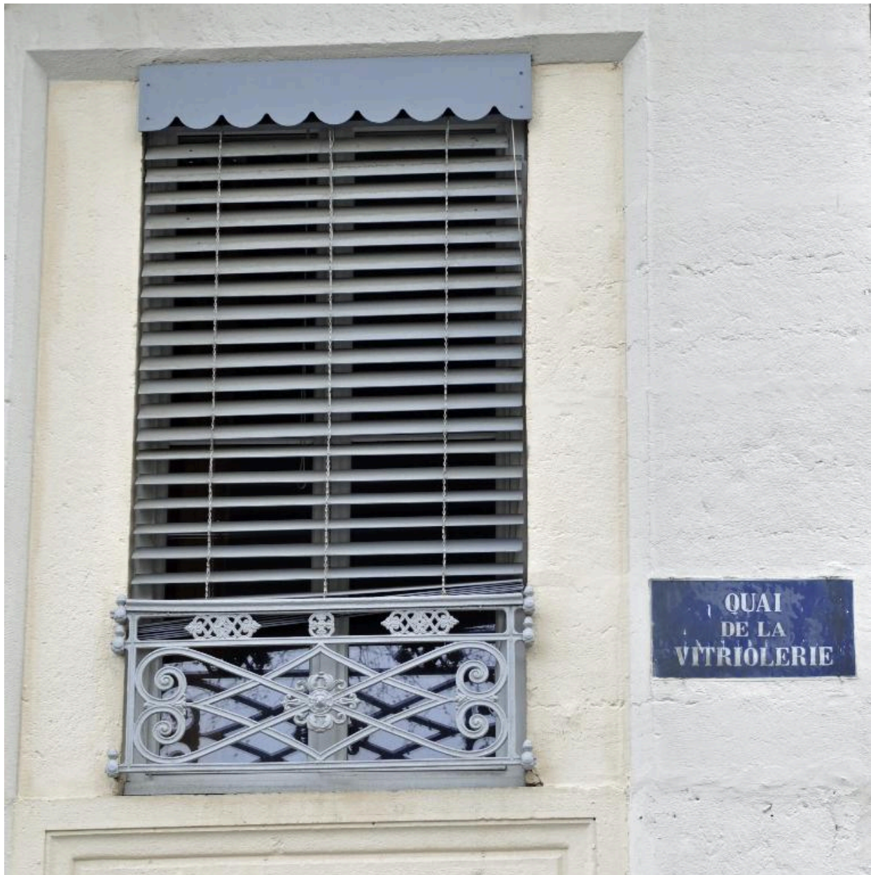
Elévation principale : fenêtre de l'étage en entresol et ancienne plaque du quai de la Vitriolerie
