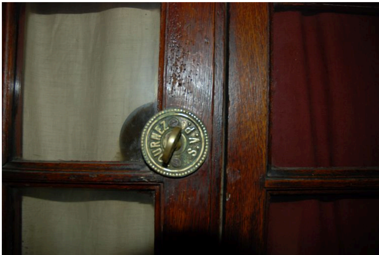
Détail de la sonnette de la porte de la loge de concierge.
