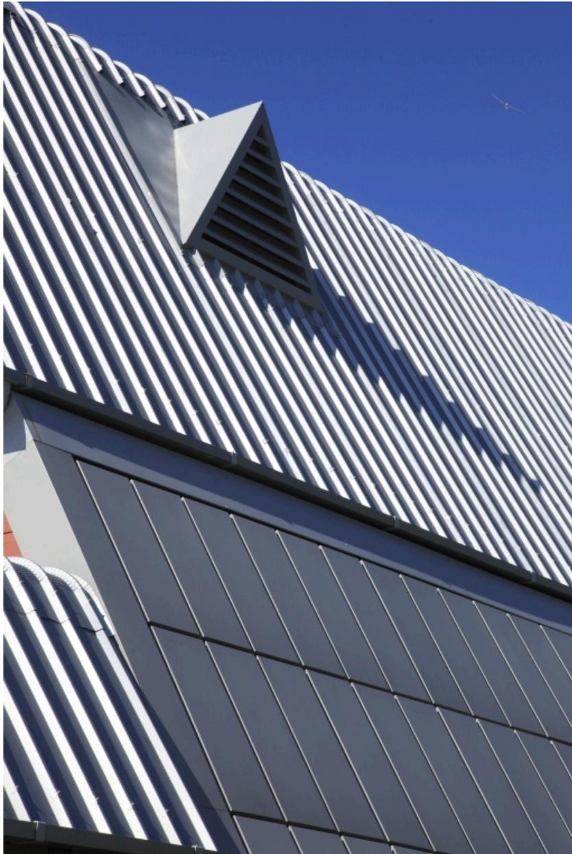
Les toitures rénovées (2006) au-dessus des panneaux solaires inclinés à 60°.
